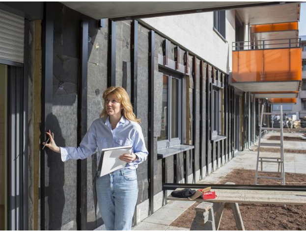
Gebäudeenergieberater/in (227720) Auf einer Baustelle die Wärmedämmung an einem Neubau überprüfen
