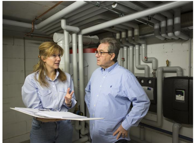
Gebäudeenergieberater/in (227689) Hausbesitzer über Vorgaben der Energiesparverordnung informieren
